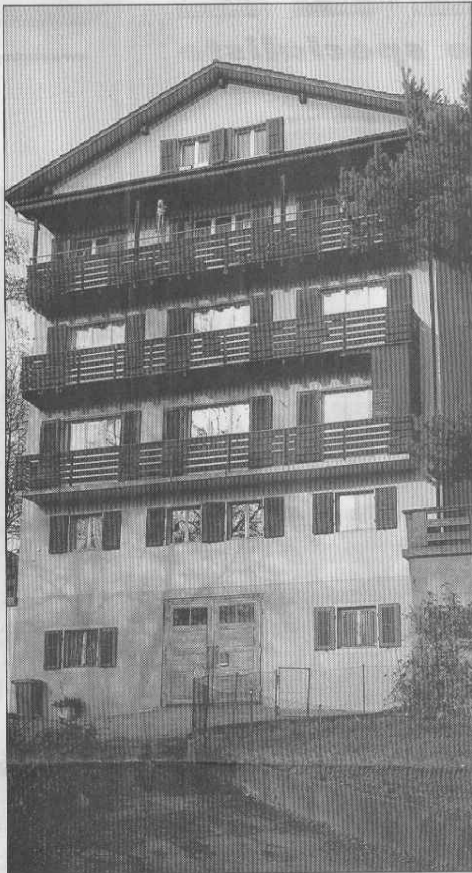
La Tuile déménage dans cet immeuble de la route de Marly. Le nouveau centre d'accueil doit ouvrir ses portes au mois de juin. ALAIN WICHT
